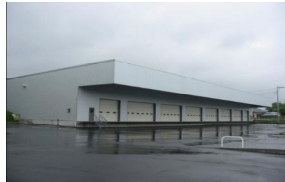
No. 0365／山武郡365倉庫 所在地：千葉県山武郡 構造：鉄骨造 鉄板葺 平屋建 管理面積：900坪
